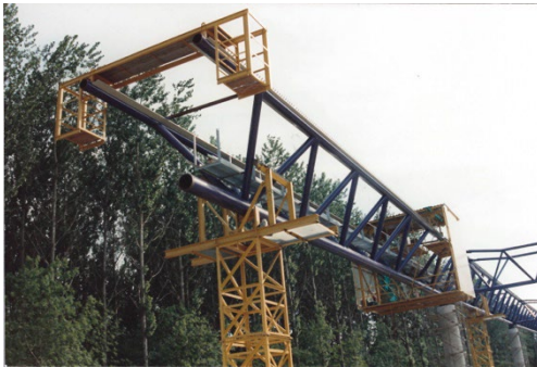
Montage des Stahlträgers
