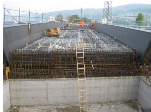
Vorfabrizierten Stahlbetonplatten als Schalung
