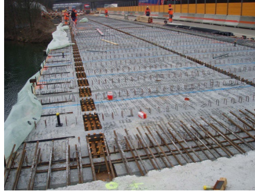
Vorfabrizierte vorgespannte Stahlbetonplatten als Schalung
