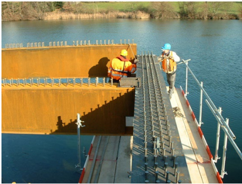
Montage mit Pneukran
