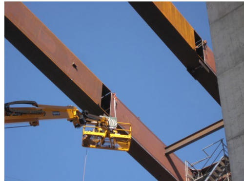
Montage mit Pneukran
