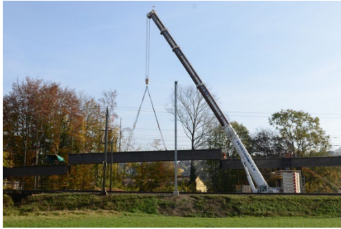
Montage mit Pneukran
