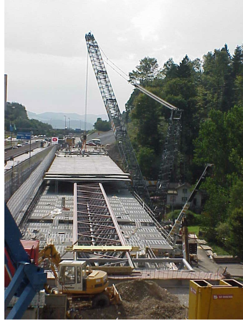
Montage der Fahrbahnplatte
