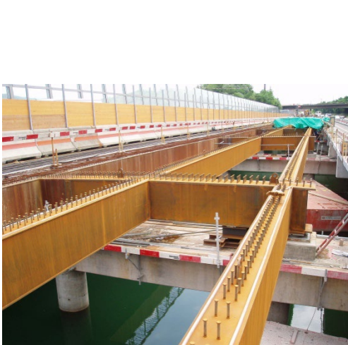
Kastenträger bei der Montage
