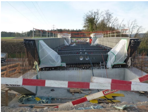
Trogquerschnitt mit Dübeln
