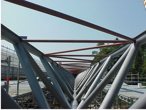
Querschnitt mit Windverband
