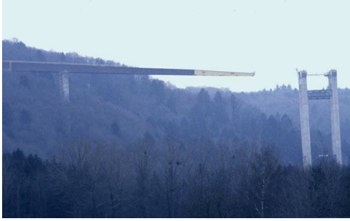
Taktschiebeverfahren Stahlkasten*
