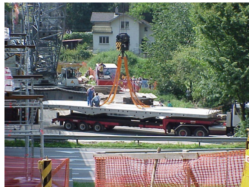
Montage Fahrbahnplatte mit Pneukran
