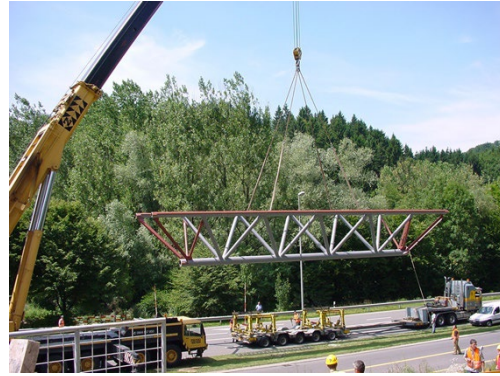
Montage Stahlfachwerk mit Pneukran
