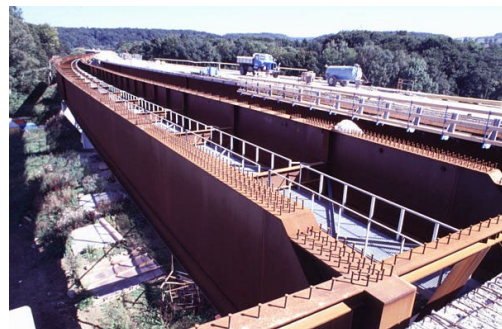
Stahlträger beim Widerlager*
