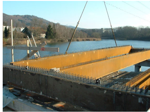
Montage mit Pneukran
