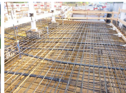
Bewehrung mit Quervorspannung
