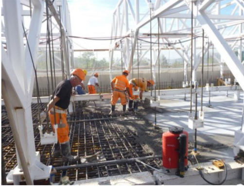
Betonieren der Fahrbahnplatte
