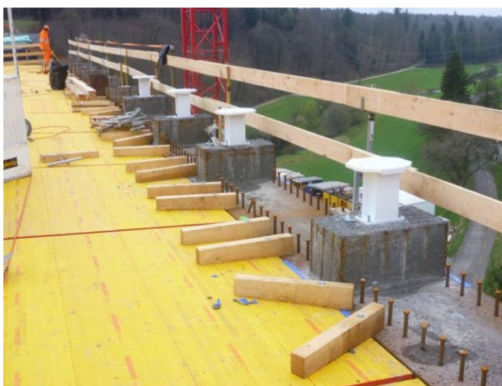
Auflagerklötze für Schalwagen
