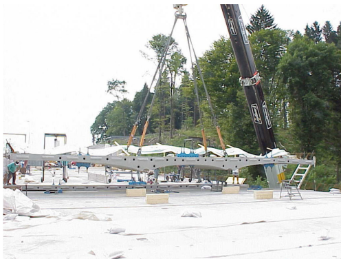
Montage Fahrbahnplatte mit Pneukran
