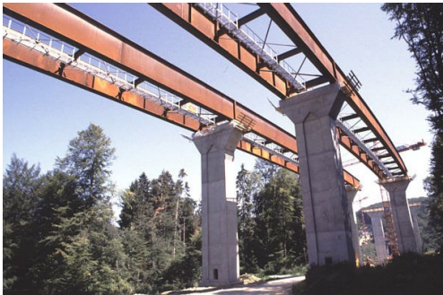
Kranmontage Plattenbalken*
