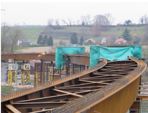
Montage auf Hilfsabstützungen
