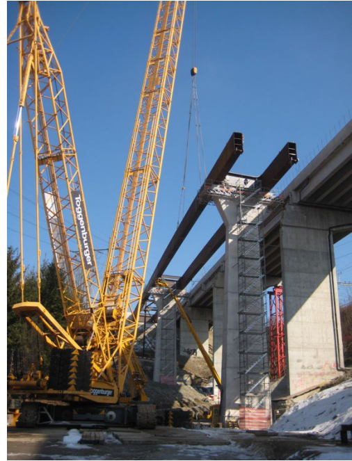
Montage mit Pneukran
