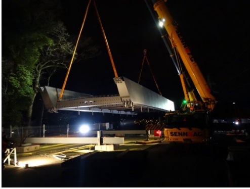
Montage mit Pneukran
