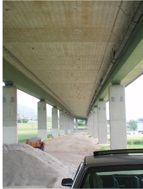
Kastenträger und Fahrbahnplatte
