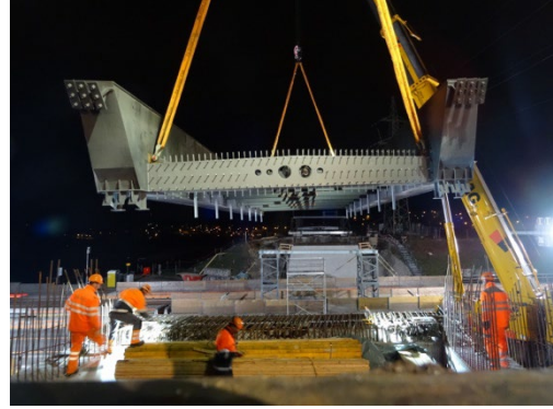
Montage mit Pneukran
