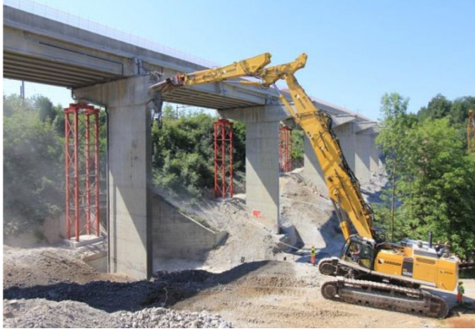
Abbruch Hammerkopf mit 190t Bagger
