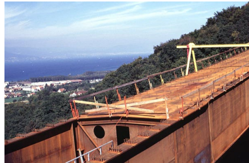
Übergang Kasten - Stahlträger*
