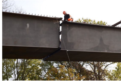
Zusammenbau der Trägerelemente
